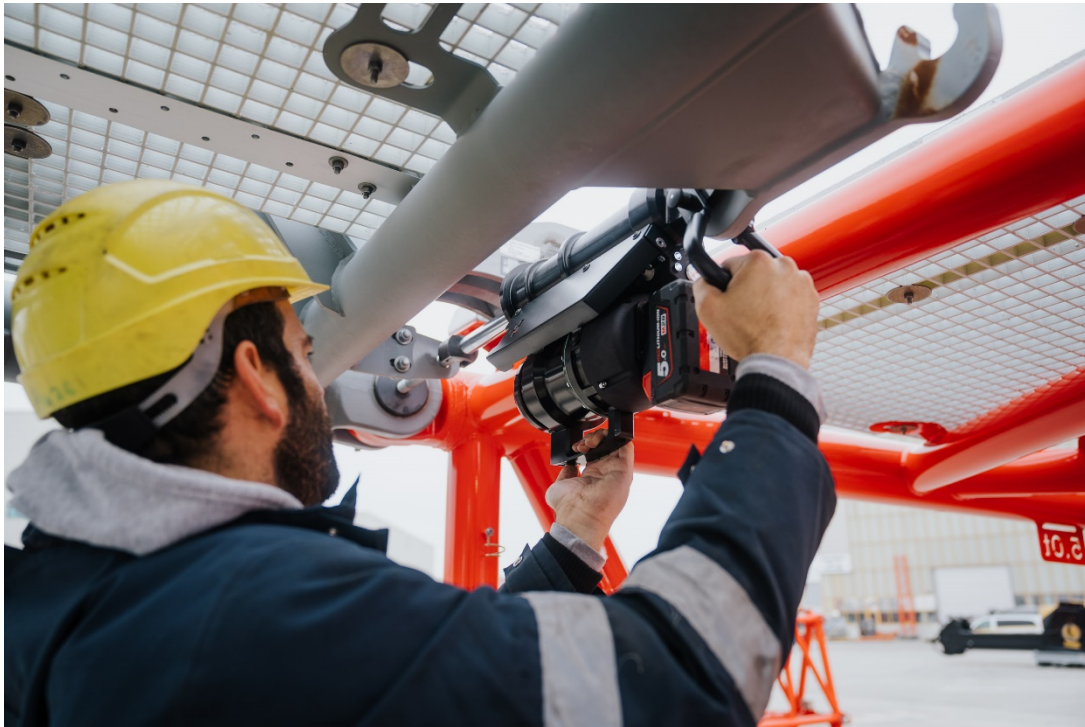
Bildunterschrift: Akku-Bolzenziehzyylinder im Einsatz
